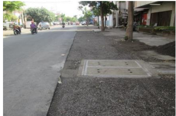
Gambar 3.16 Pembangunan Saluran Jl. S. Parman dan Kawasan Sekitarnya
