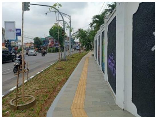
Gambar 3.4 Peningkatan Jalan Ki Hajar Dewantoro
