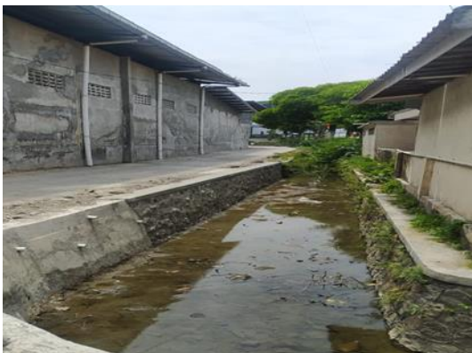
Gambar 3.11 Pembangunan Saluran Drainase Primer Sumber
