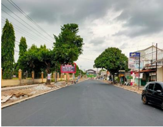
Gambar 3.1 Peningkatan Jalan Joko Tingkir
