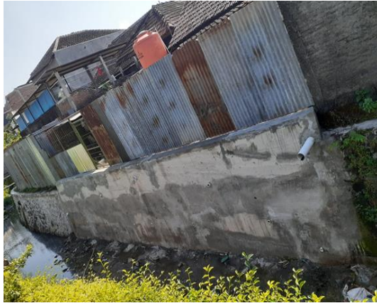
Gambar 3.13 Pembangunan Talud Kedung Jumbleng
