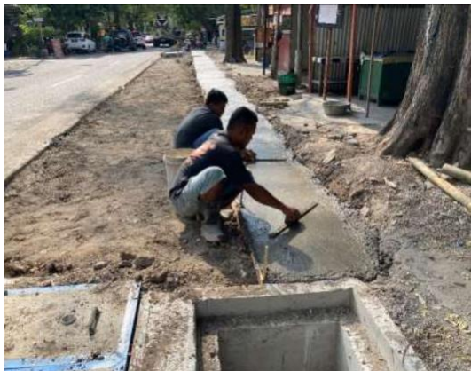
Gambar 3.17 Peningkatan Saluran Jl. Kebangkitan Nasional
