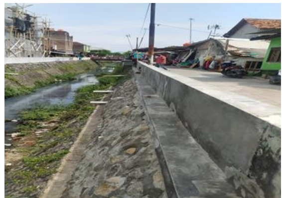
Gambar 3.12 Pembangunan Talud Kali Makam Bergolo
