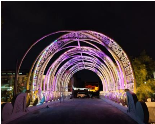
Gambar 3.9 Pembangunan Jembatan Ketandan
