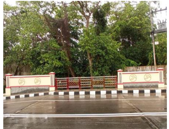
Gambar 3.10 Pembangunan Jembatan Jonasan
