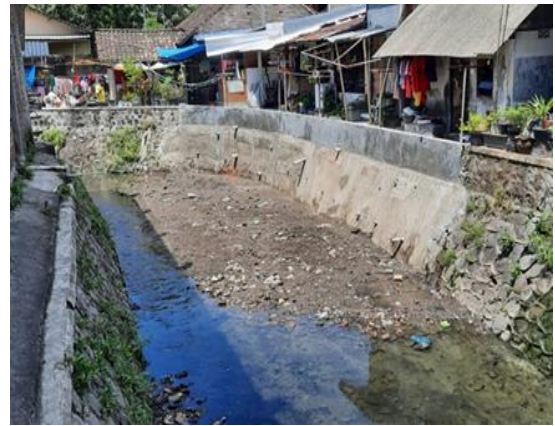
Gambar 3.14 Perbaikan Talud Kali Toklo
