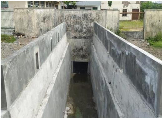
Gambar 3.15 Pembangunan Talud Saluran Stadion Mini
