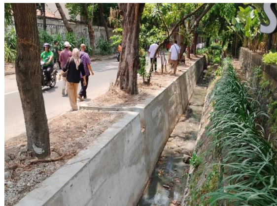
Gambar 3.2 Peningkatan Infrastruktur (Perbaikan Talud Drainase Primer)
