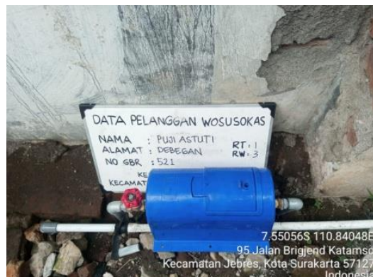
Gambar 3.42 Pemasangan Sambungan Rumah Jaringan Air Minum
