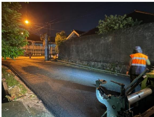
Gambar 3.7 Rehabilitasi Jalan Nakulo
