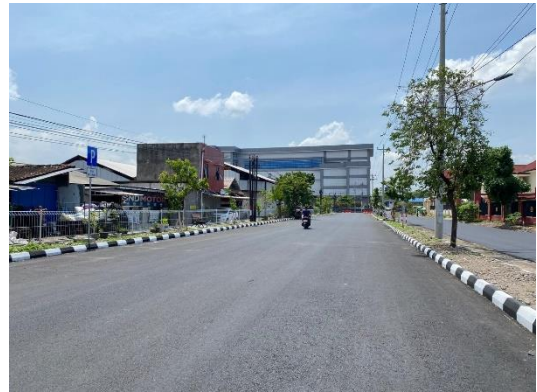
Gambar 3.14 Rehabilitasi Jalan Nyi Ageng Serang
