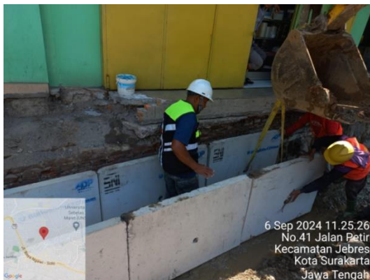
Gambar 3.17 Pembangunan Drainase sisi Barat ISI Surakarta
