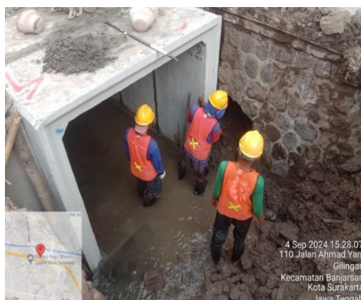
Gambar 3.20 Pembangunan Drainase Jl. Achmad Yani
