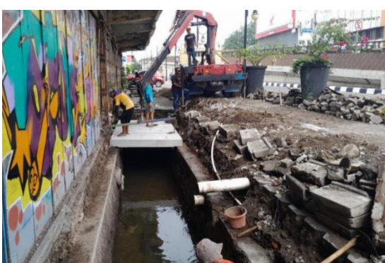
Gambar 3.12 Pemeliharaan Fly Over, JPO & Underpass
