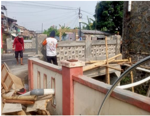
Gambar 3.13 Pemeliharaan Rutin Jembatan
