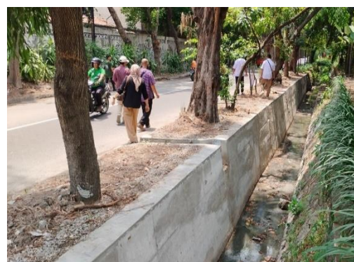
Gambar 3.16 Perbaikan Talud Drainase Primer
