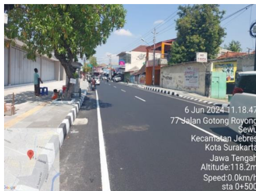
Gambar 3.9 Rekonstruksi Jalan Gotong Royong
