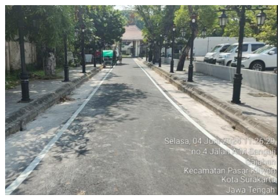
Gambar 3.8 Rekonstruksi Jalan Reksoniten
