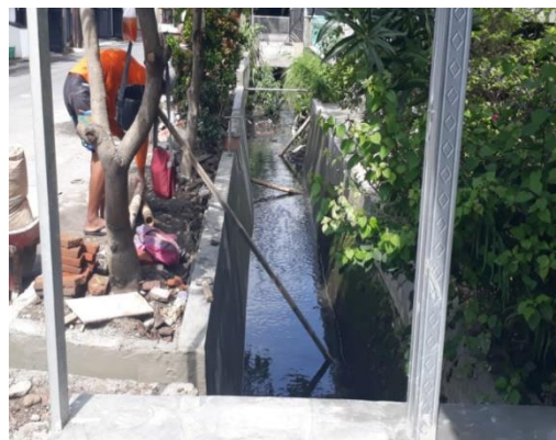
Gambar 3.18 Pembuatan Jalur Inlet Jalan Kenanga
