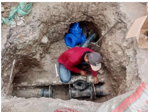
Gambar 3.41 Pemasangan Jaringan Air Minum
